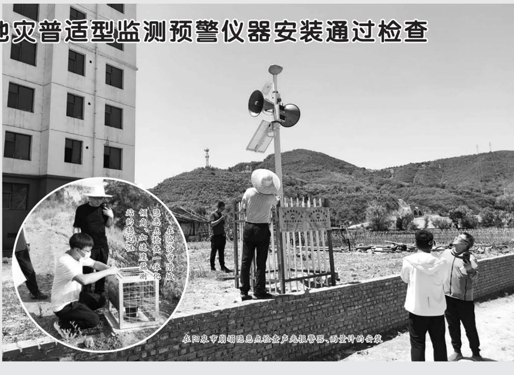
在阳泉市崩塌隐患点检查声光报警器、雨量计的安裝
