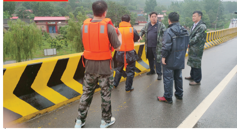
受连续降雨的影响, 地质灾害发生风险陡升。河南省修武县自然资源局迅速启动地质灾害防治应急响应, 联合技术人员对地质灾害隐患点全面巡查评估。图为工作人员巡查地质灾害隐患点。 薛海江 摄
